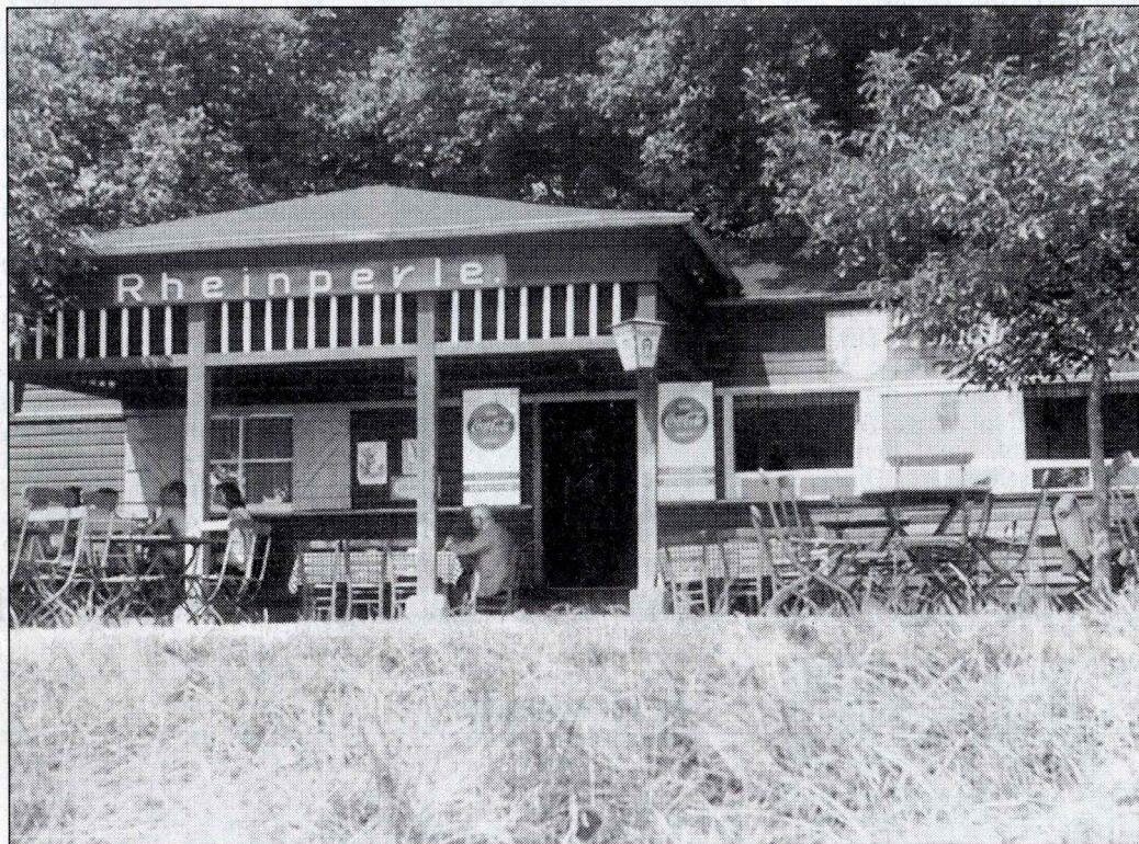
Der alte Holzbau der „Rheinperle“ wurde 1928 von Jakob und Helene Riedel errichtet. Unweit des heutigen Segelflughplatzes entstand damals ein kleines Paradies der Gastlichkeit. Bild: privat
